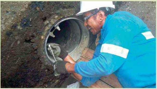
Las válvulas, ya instaladas, evitan el paso del flujo de aguas lluvias en dirección contraria y evitan los perjuicios de una marea alta.
