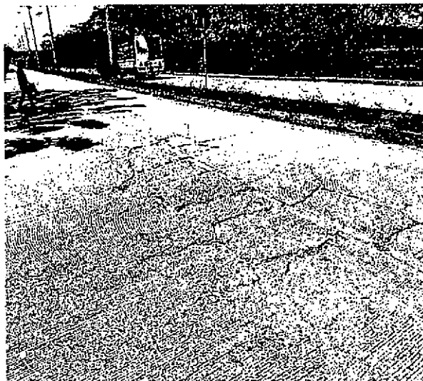
FOTO 2.- Grietas transversales en Pavimento
