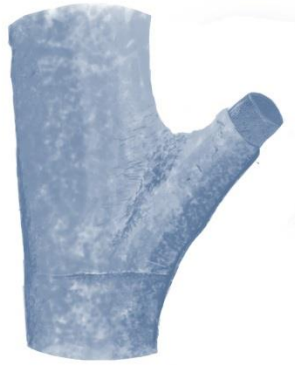
Ilustración 20: Tocón seco en rama por una poda incorrecta.
