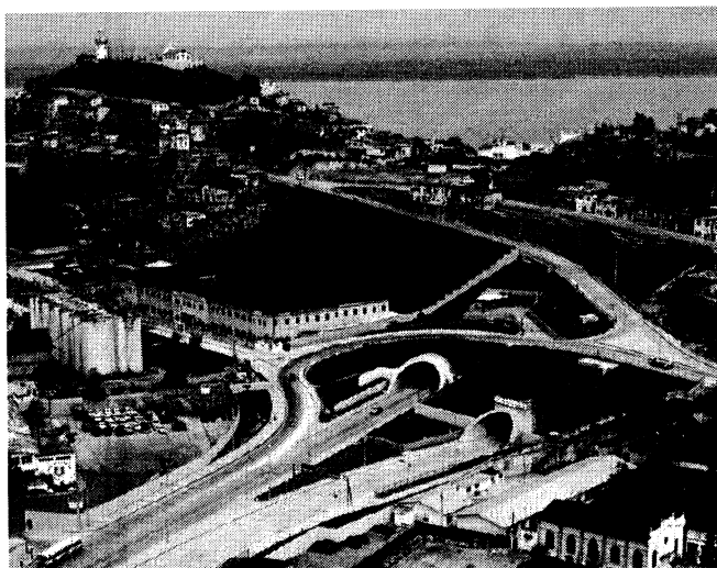
Foto 2-4: Túnel bajo el Cerro Santa Ana y El Carmen
