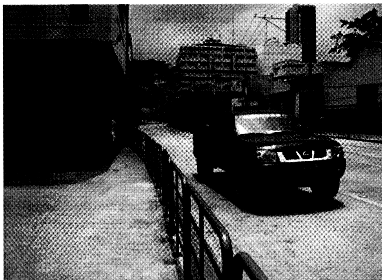
Foto 6-5: Diseño defectuoso de acera parada San Agustin.
