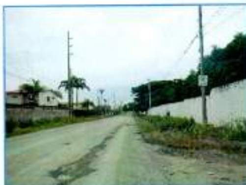
Imagen 04.- Situación actual de la Avenida 70 N-O
