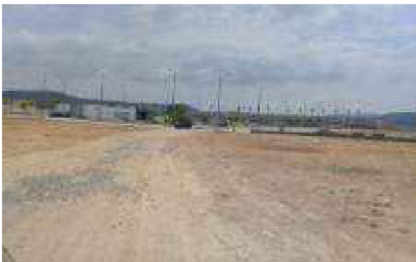
Fotografía 5: Vista del área destinada al área de construcción del proyecto de estación de servicio NEXUS.
