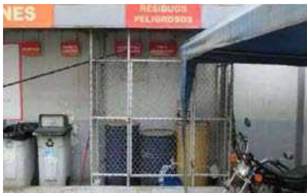
Fotografía 5-6: Vista del área de almacenamiento de desechos domésticos y desechos peligrosos de la estación de servicio. Se observa cerramiento perimetral completo. No se evidenció extintor exclusivo para el área.
