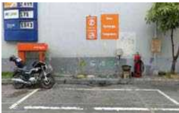
Fotografía 9: Área de descarga de combustible. Se observa el área de bocas de llenado, recipientes con arena y señalética.
