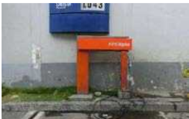
Fotografía 19: Servicio de agua y aire para clientes.
