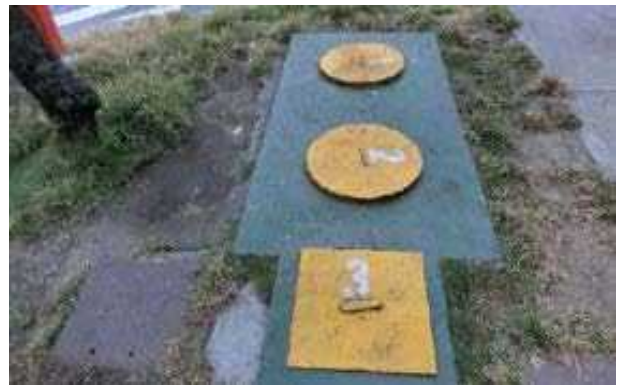
Fotografía 14: Sistema segregado de trampa de grasas de la estación de servicio.
