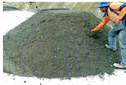
Después de que se haya tendido se pasará el rodillo y efectuara la compactación hasta alcanzar la densidad deseada. Una vez chequeado que se hayan cumplido con las especificaciones técnicas del material y que hayan chequeado los niveles se ubicará una nueva capa y se repite el procedimiento anterior, y así hasta alcanzar la cota prevista en los planos para el material de préstamo importado.
