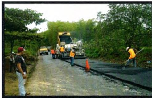
Transcurrido al menos 48/ horas, se dará inicio a los trabajos de colocación de la Carpeta Asfáltica. Para ello se procederá a colocar la carpeta asfáltica sobre las áreas ya imprimadas. El equipo que se empleará está conformado por: distribuidor de asfalto, escoba mecánica, finisher, rodillo doble tambor, rodillo neumático, mini cargadora y volquetas con lona en número suficiente para mantener la continuidad del trabajo.
